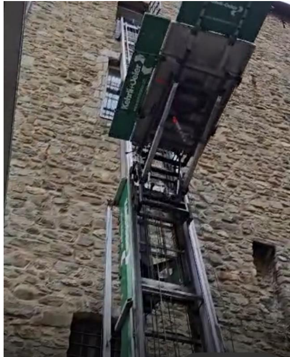
Kehlri & Oehler en pleine action au Château de Bulle
